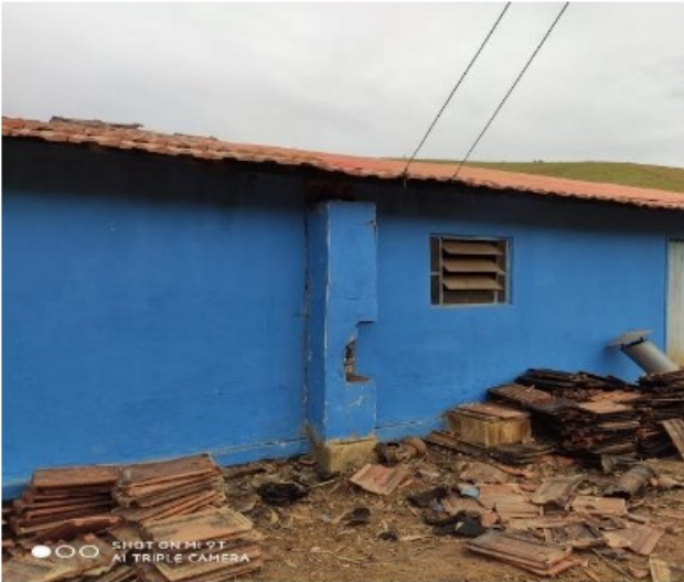
Foto 21: Início da reforma do imóvel.
