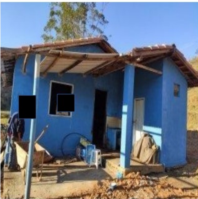
Foto 25: Pintura externa concluída.
