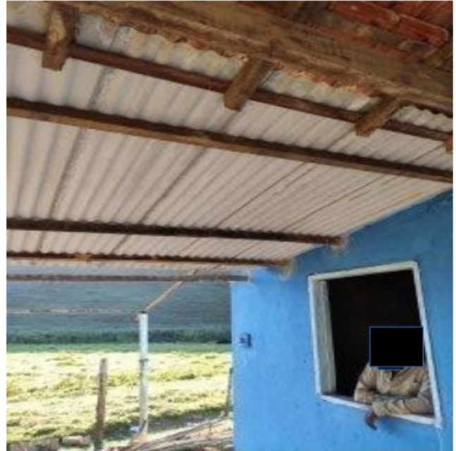
Foto 24: Telhas externas novas.
