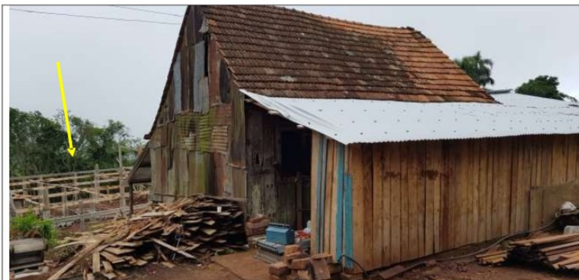
Imagem da obra de construção que estava sendo realizada no estabelecimento rural. Na antiga edificação em madeira eram guardadas ferramentas, máquinas, armazenado o milho, e havia um quarto para abrigar trabalhadores.
