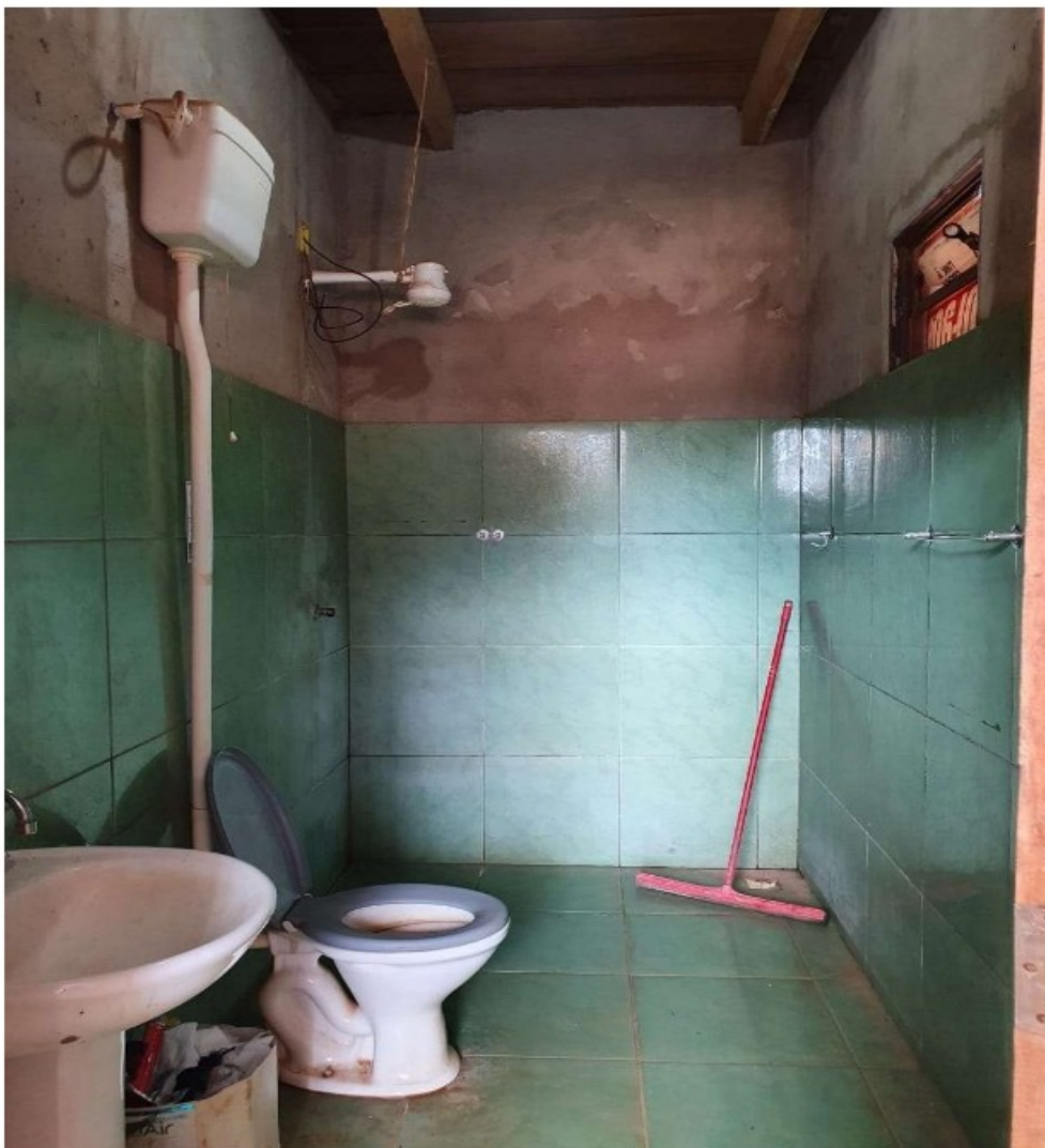
Foto 03. Instalação sanitária dos empregados.
