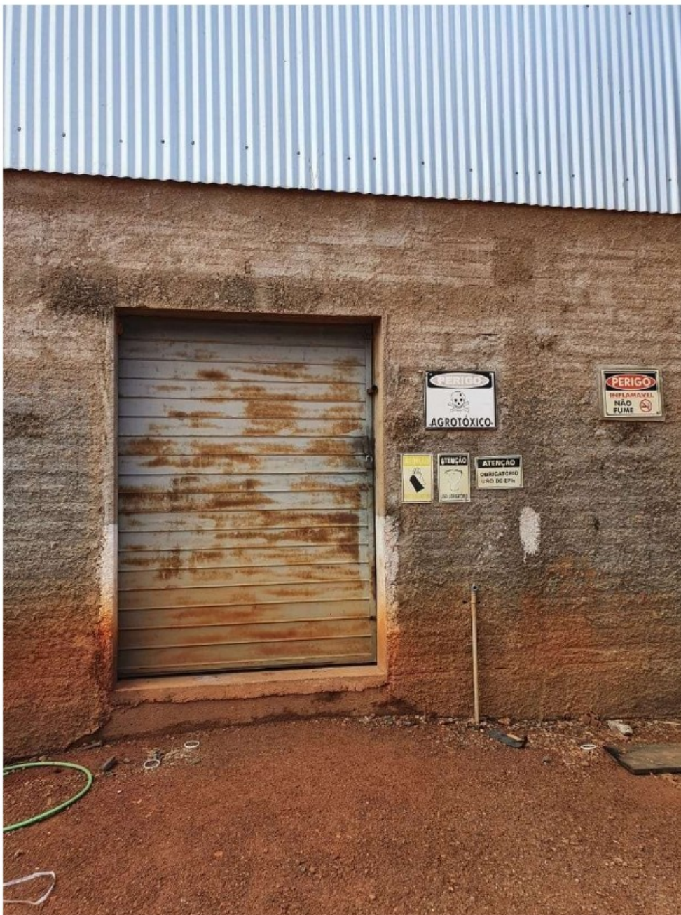
Foto 08. Entrada ao armazenamento de agrotóxicos dentro do barracão.
