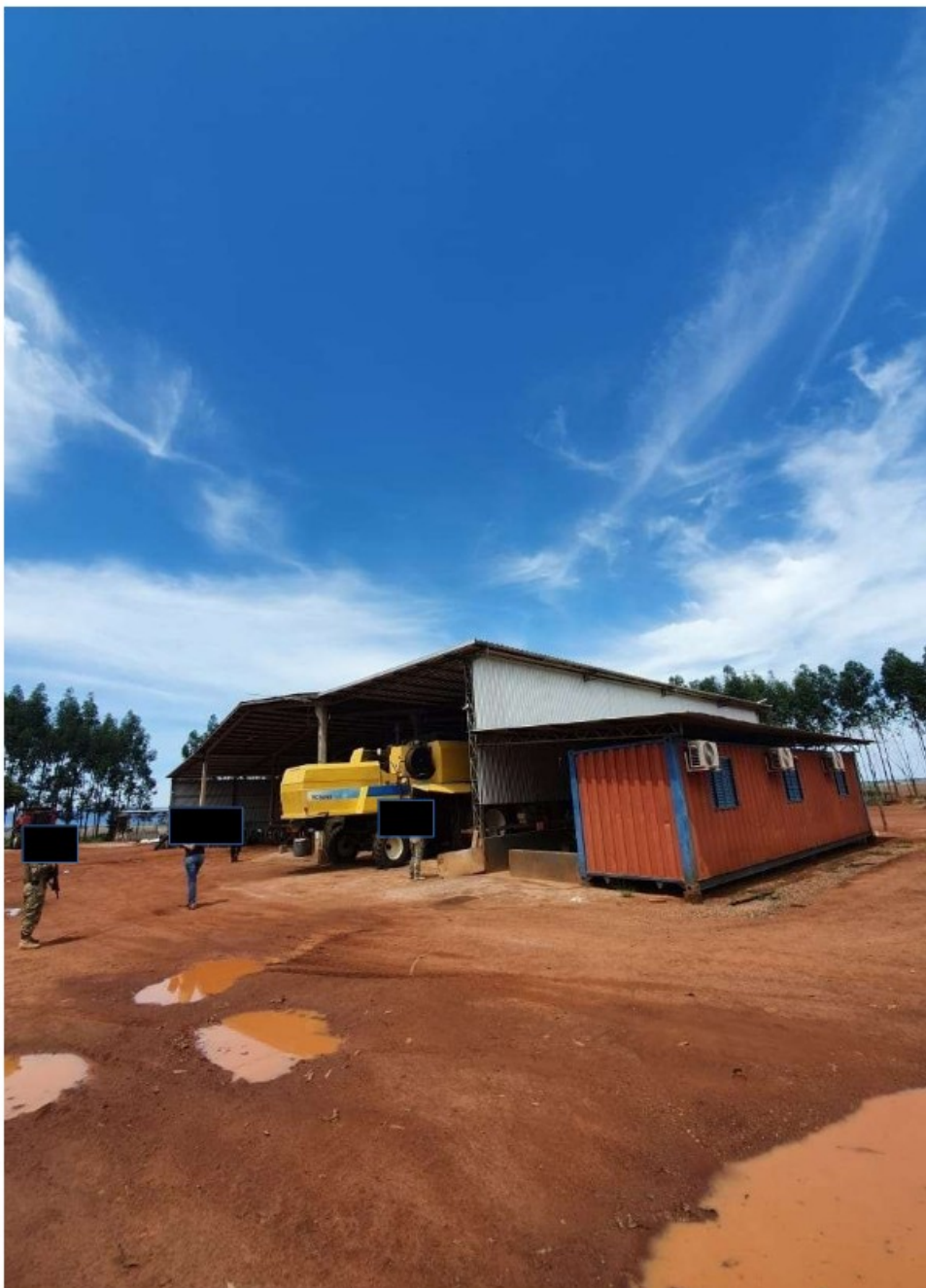
Foto 04. Barracão com container oficina e garagem de máquinas agrícolas e armazenamento de agrotóxicos embalagens cheias.
