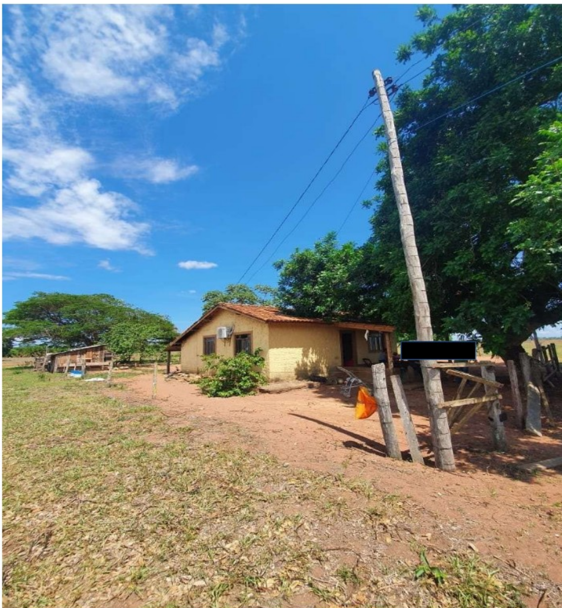
Foto 15. Casa de empregado.
