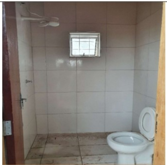
Foto: banheiro do alojamento definitivo
