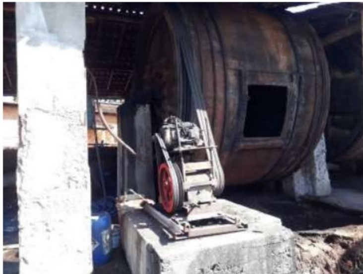
Foto 05. Fulão, equipamento utilizado no curtimento do couro, sem a proteção das correias.
