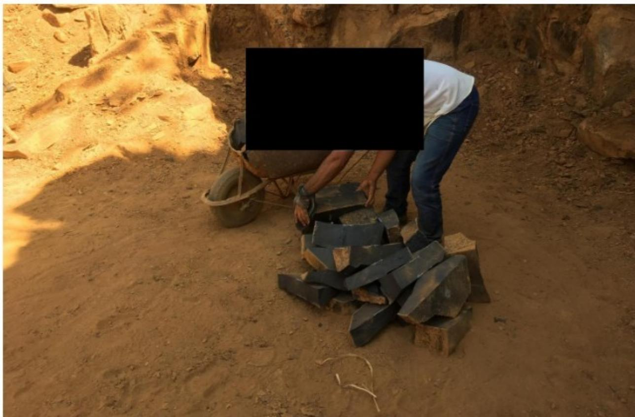
**Imagem 05** – Trabalhador em postura prejudicial, realizando atividade de carregamento e transporte manual de rochas, sem fazer uso dos equipamentos de proteção individual necessários (óculos, luvas, proteção contra insolação excessiva, botinas de segurança etc).
