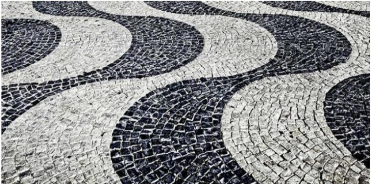
**Imagem 02** – Fotografia ilustrativa de uma calçada revestida com “Pedra Portuguesa”, material de construção semelhante ao extraído na “Pedreira do [REDACTED]”.
