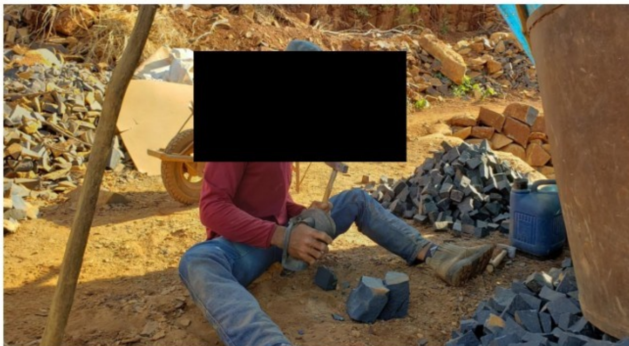
Imagem 05 – Trabalhador quebrando pedras fazer uso dos equipamentos de proteção necessários (luvas, máscaras e óculos), com risco de acidentes e doenças ocupacionais.
