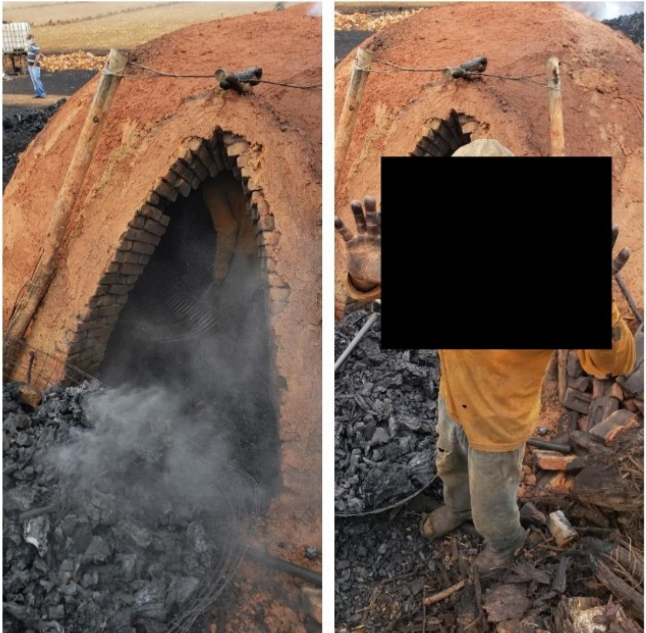
Imagens 03 e 04 – Um dos carbonizadores da carvoaria [REDACTED], laborando sem nenhum equipamento de proteção individual.
