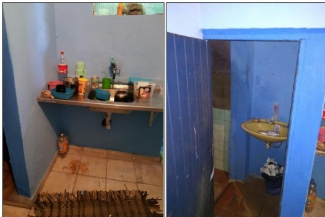
Fotos 17 e 18: pia da cozinha e instalação sanitária do alojamento dos trabalhadores.
