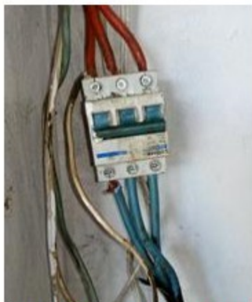
Disjuntores sem fixação, área viva exposta, com riscos de choques elétricos
