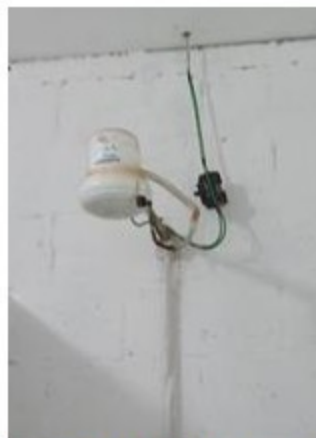
Disjuntores sem fixação, área viva exposta, com riscos de choques elétricos
