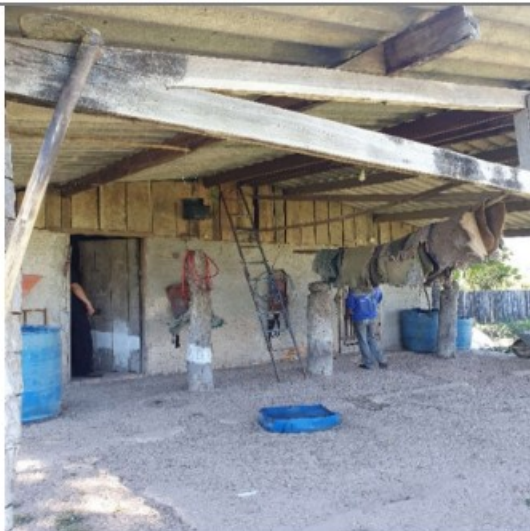
Foto: Local de armazenamento de materiais e ferramentas de trabalho
