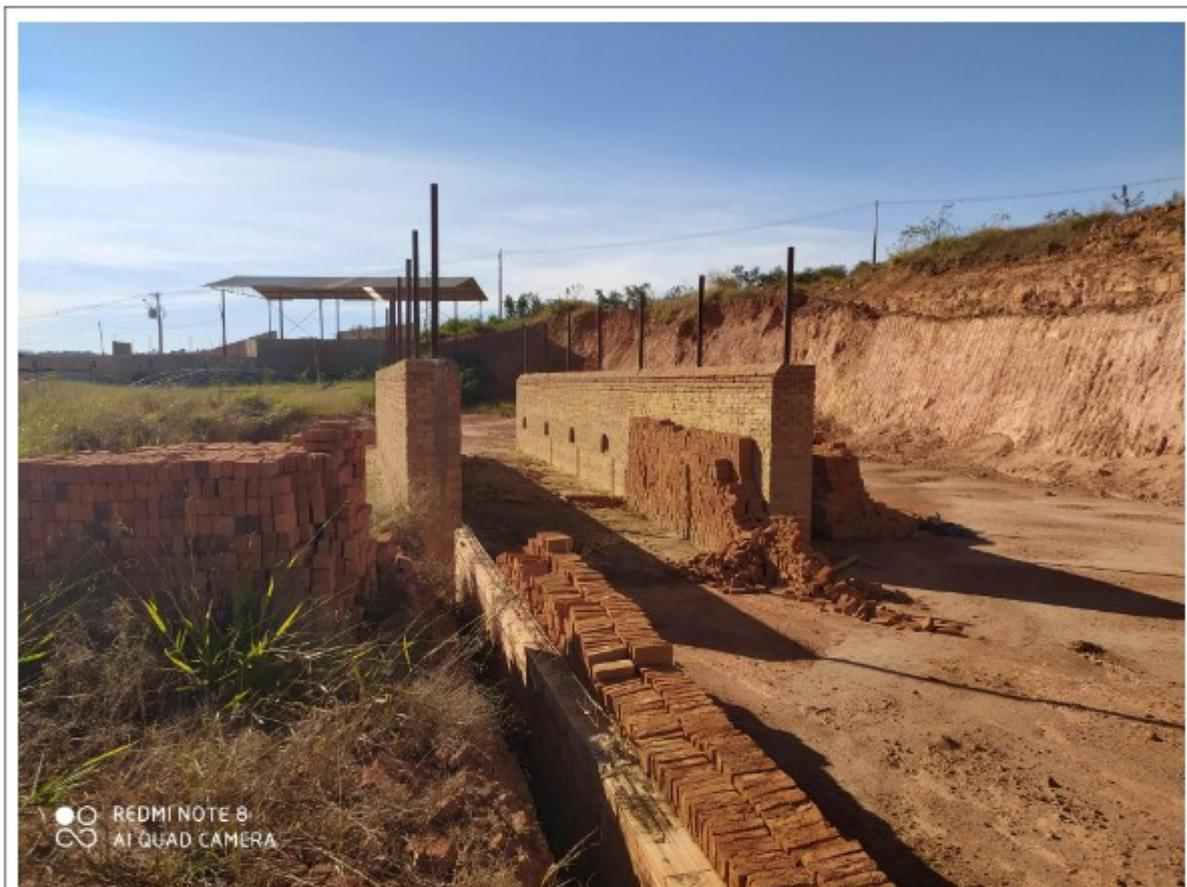
*Foto 2: Forno em construção e tijolos refratários*
