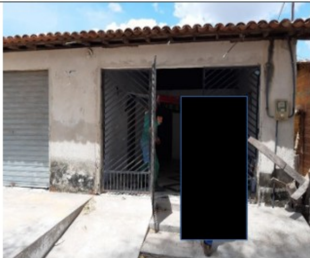
Alojamento dos trabalhadores
