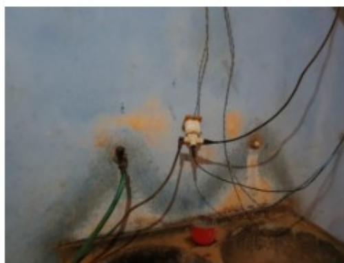
Fotos 1 e 2 - Gambiarras elétricas no corredor do alojamento com vários aparelhos ligados de forma improvisada numa só tomada
