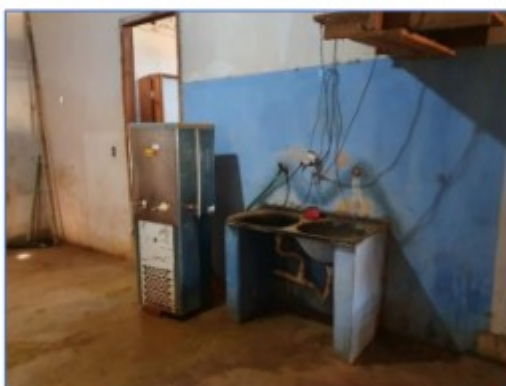
Fotos 1 e 2 - Gambiarras elétricas no corredor do alojamento com vários aparelhos ligados de forma improvisada numa só tomada
