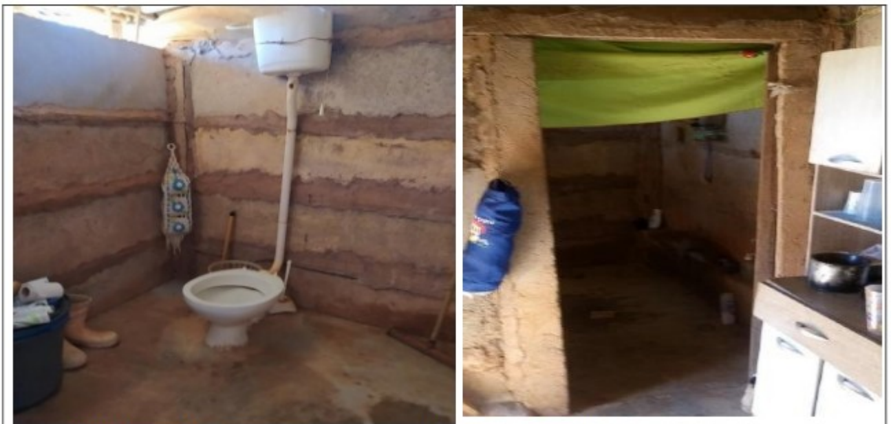
Figura 6: Banheiro, abertura na parte superior e lona na porta de entrada
