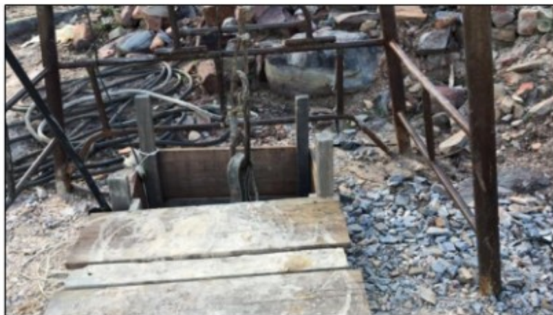
Imagem acima: Detalhe da abertura do poço.
