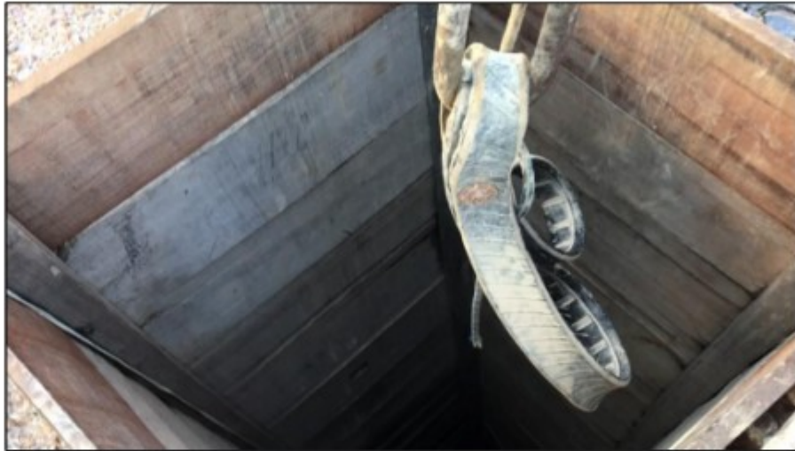
Imagem acima: Detalhe da abertura da mina com o "cavalo" utilizado para içar trabalhadores.
