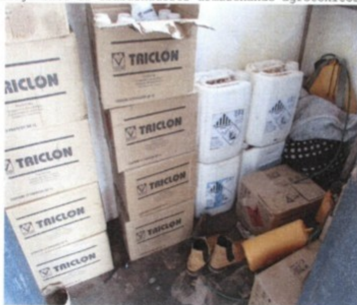
Na imagem vê-se o interior do local de armazenamento de agrotóxicos. É possível notar que os produtos não ficam dispostos sobre estrados, são empilhados junto às paredes, não há sistema de retenção de vazamentos e o local serve ainda à guarda de materiais diversos.
