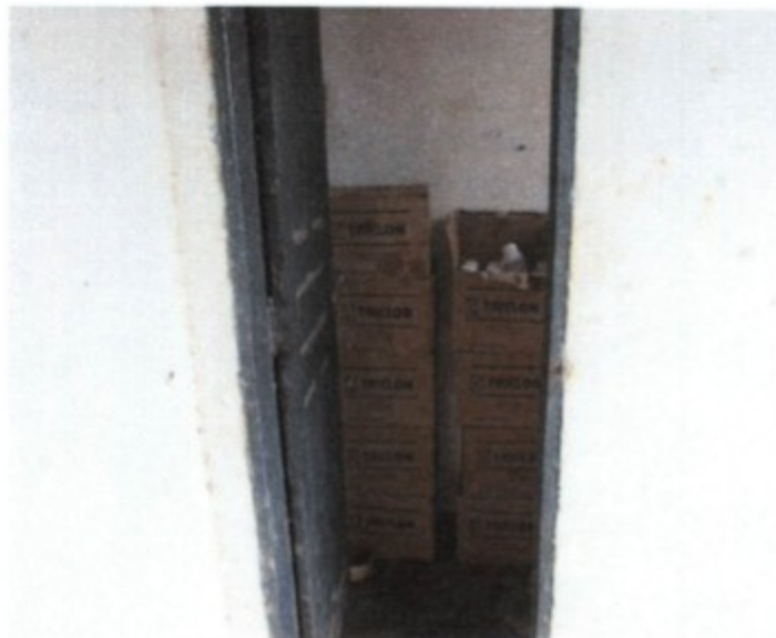
Registro fotográfico exhibe cômodo pertencente à edificação utilizada para alojamento de trabalhadores armazenando agrotóxicos.
