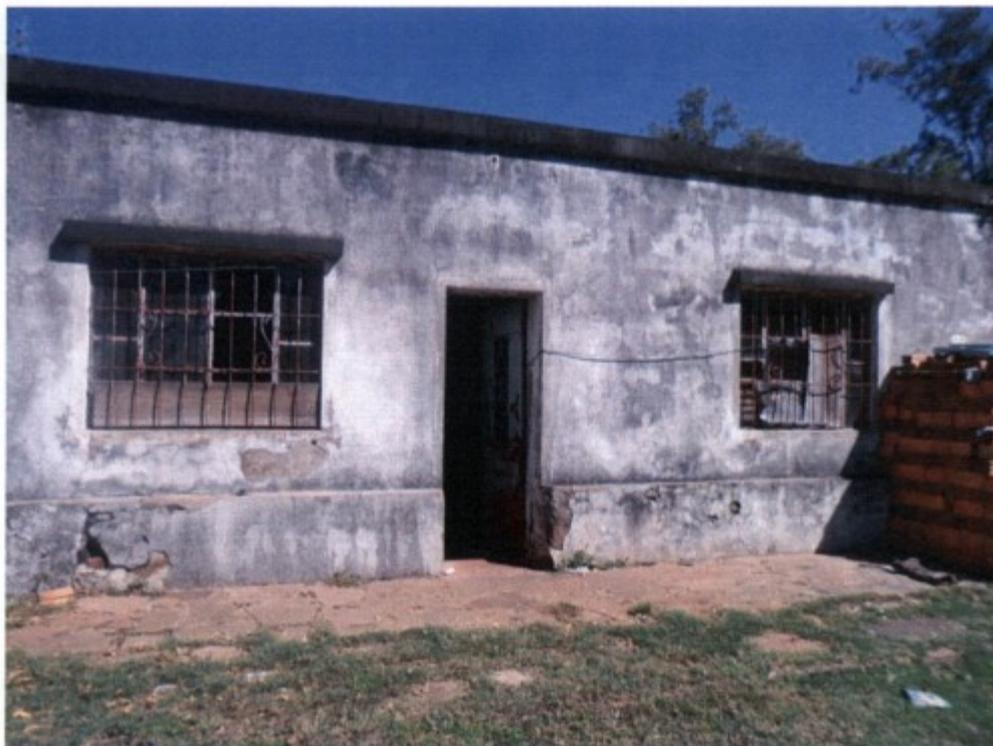
Foto 02: Entrada frontal da moradia. Podemos observar a existência de vidros quebrados nas duas janelas da moradia. A falta de vedação completa das janelas representa risco à segurança e saúde da família.
