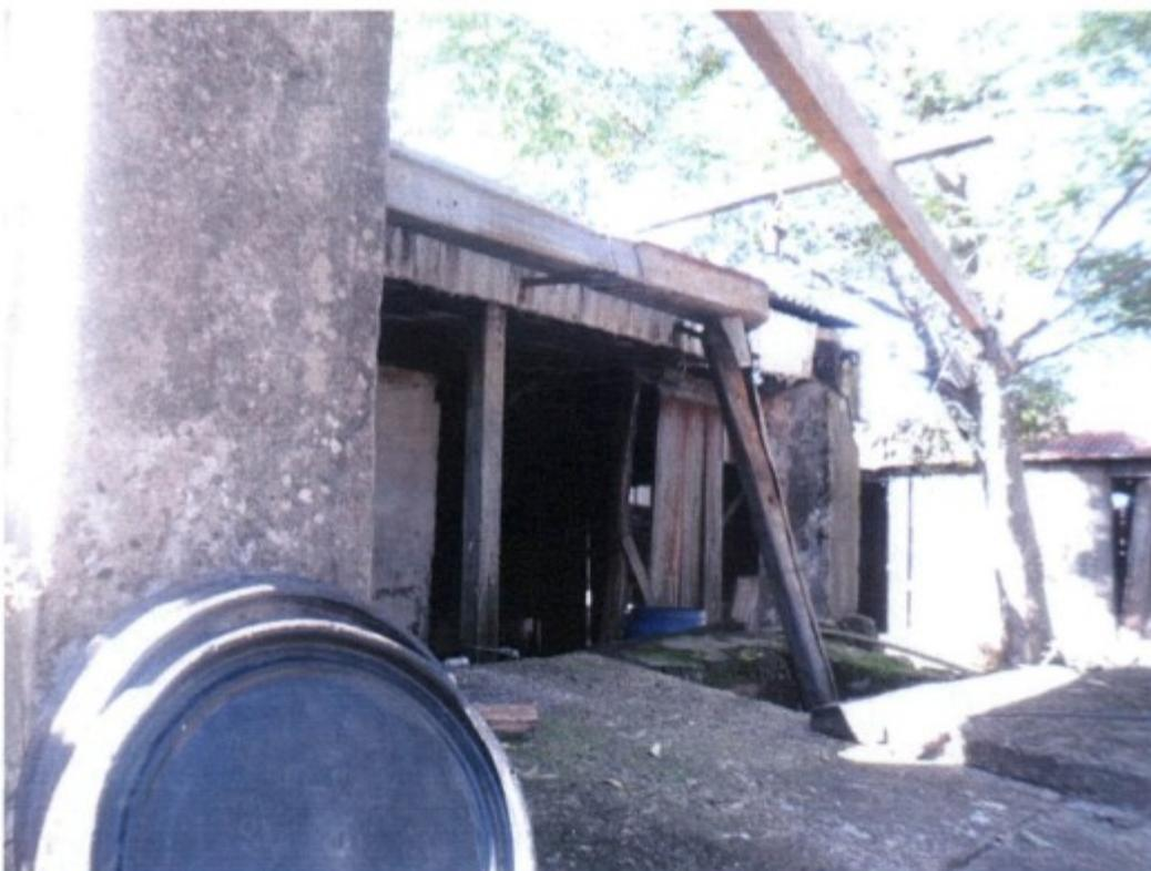
Foto 08: Calhas que direcionam água da chuva do telhado para a cisterna. Também pode ser visualizada na fotografia 07.
