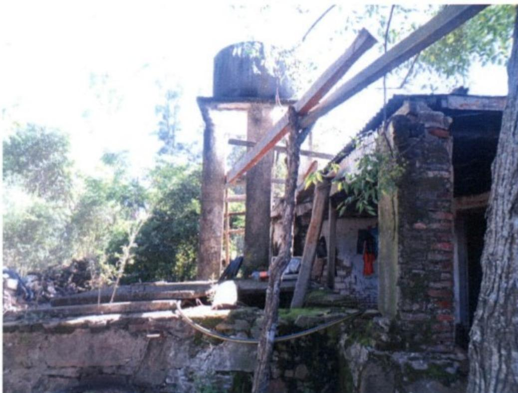
Foto 07: Caixa d'água localizada ao lado da cisterna. A caixa não está sendo utilizada por impossibilidade de se fazer água chegar até ela.
