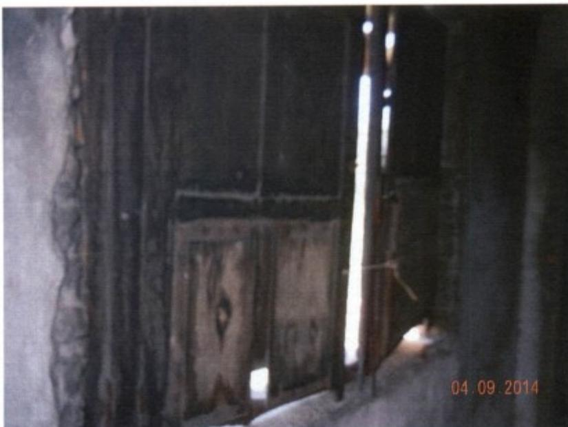
Foto 10: Um exemplo de janela com travamento quebrado. A presença de grandes frestas obstrui o conforto térmico dos alojados, sobretudo no inverno, com as baixas temperaturas. Outrossim, não impede a entrada de pequenos animais que podem representar perigo aos alojados.
