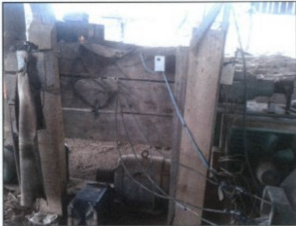
Instalações elétricas de máquinas, acarretando perigo de choque elétrico, incêndio e outros acidentes.
