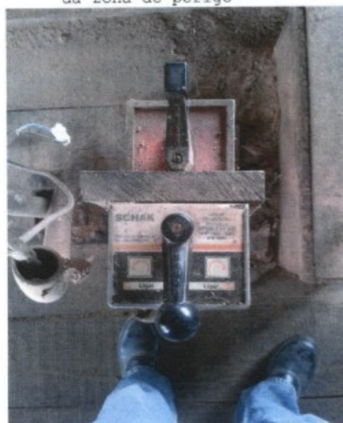
Chave tipo faca proibida pela norma
