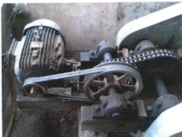
Maquina sem proteção de partes moveis e transmissão de força
