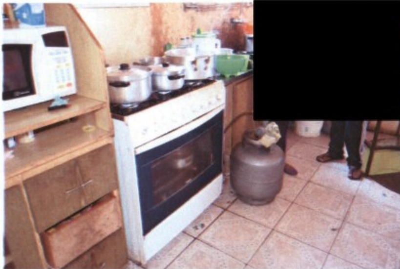
Botijão de gás liquefeito de petróleo em local fechado, sem ventilação, com risco de explosão – 14/03/2014
