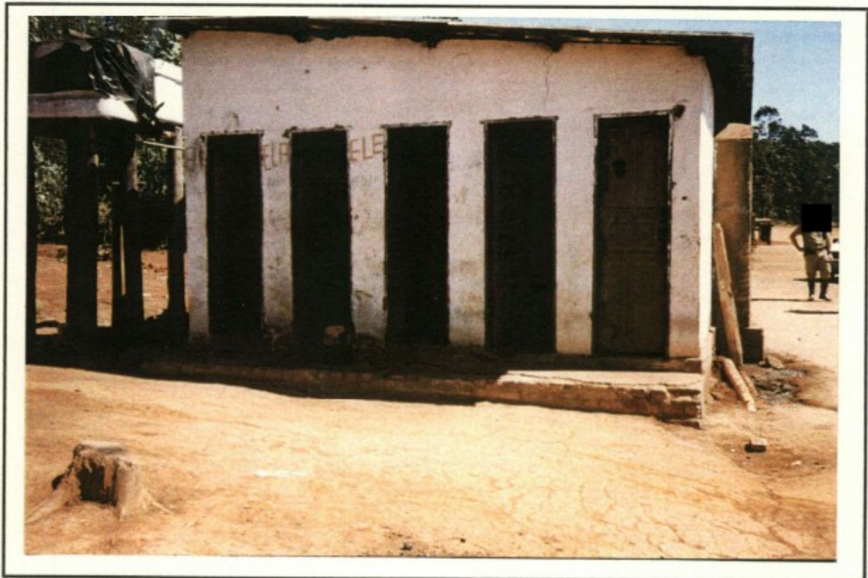
CARVOARIA DO EMPREITEIRO [REDACTED] INSTALAÇÃO SANITÁRIA SEM APARELHOS, SÓ COM AS PAREDES.
