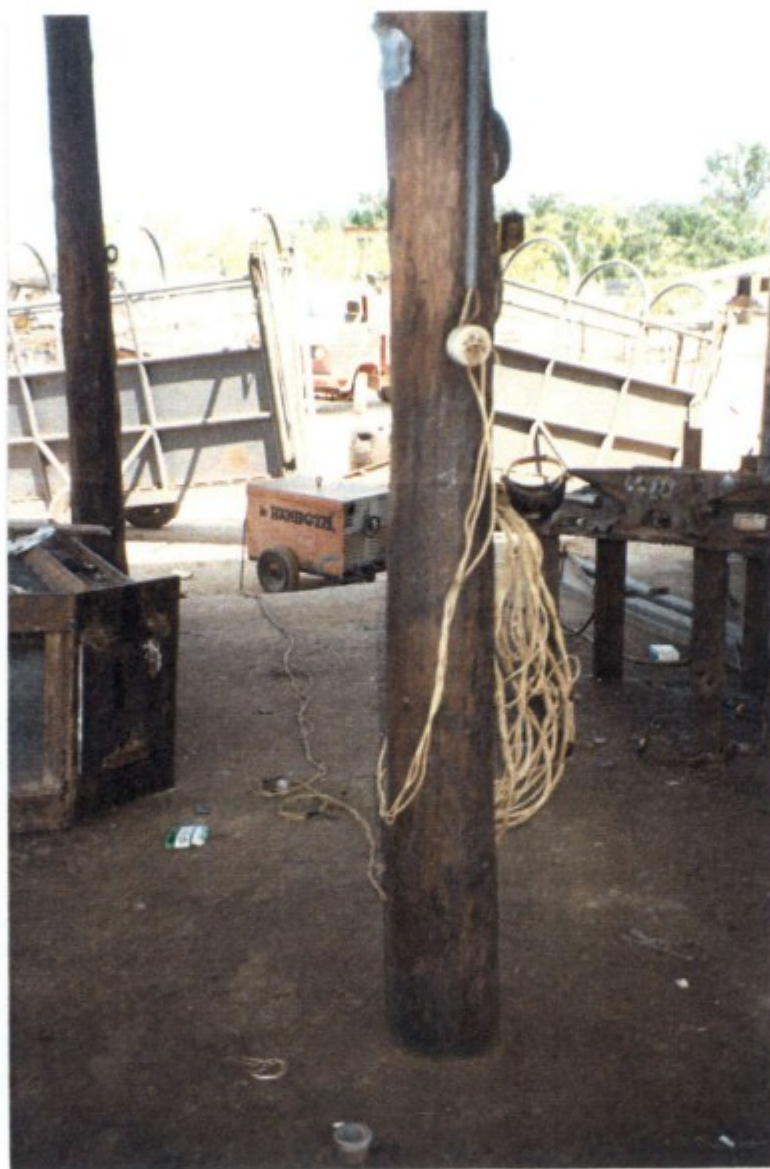
Foto 06: Risco de Choque Elétrico.
