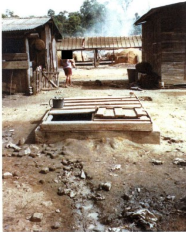
Foto 05: Tanque semi-enterrado para armazenamento de água.
