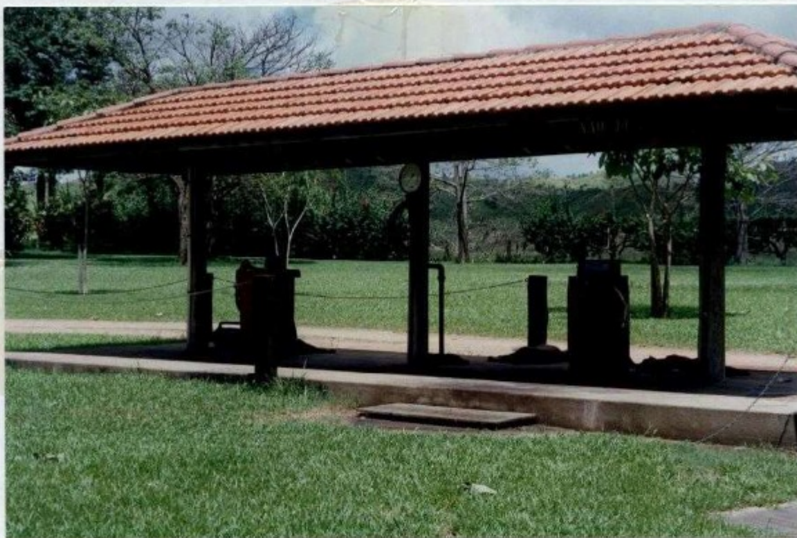
Foto 11: ausência de extintor de incêndio no posto de abastecimento de combustível.
