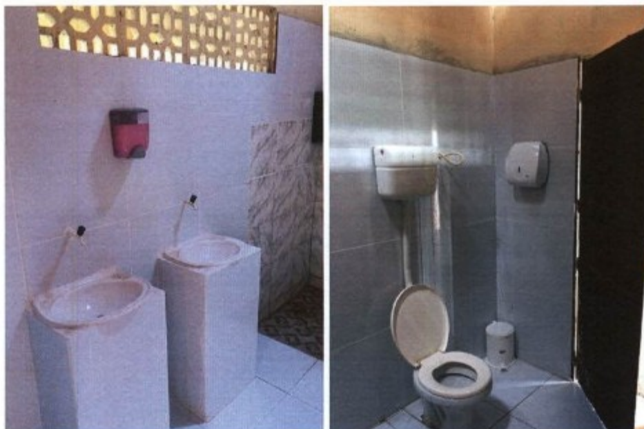
Figuras 1 e 2 Instalações sanitárias
