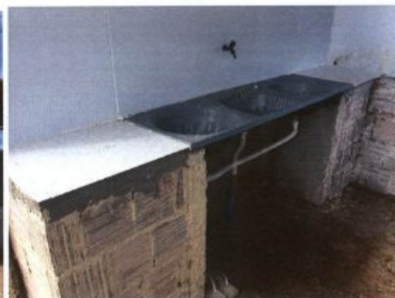
Figura 6 Lavanderia do alojamento
