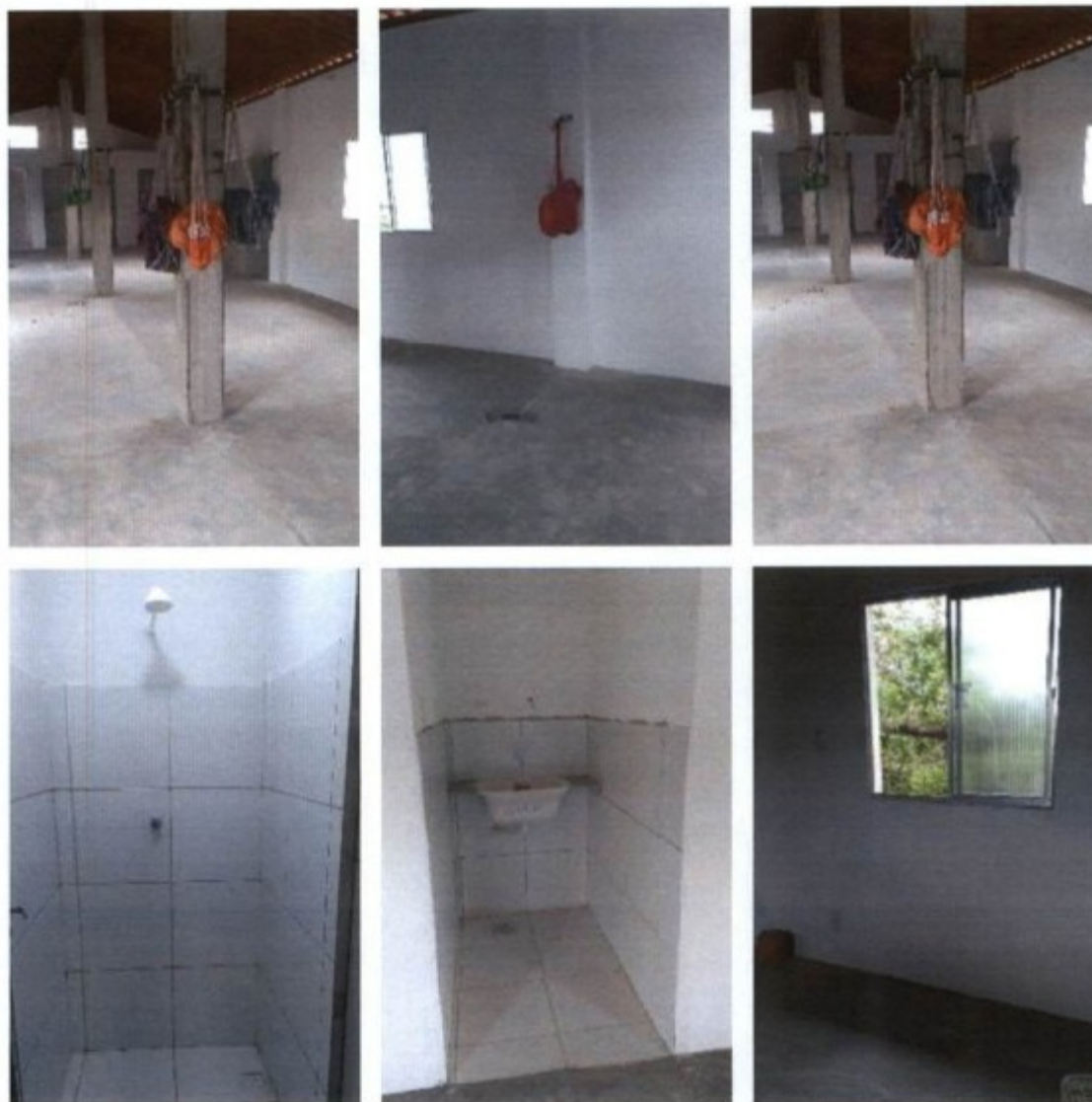
Figura 3 Novas instalações do alojamento
