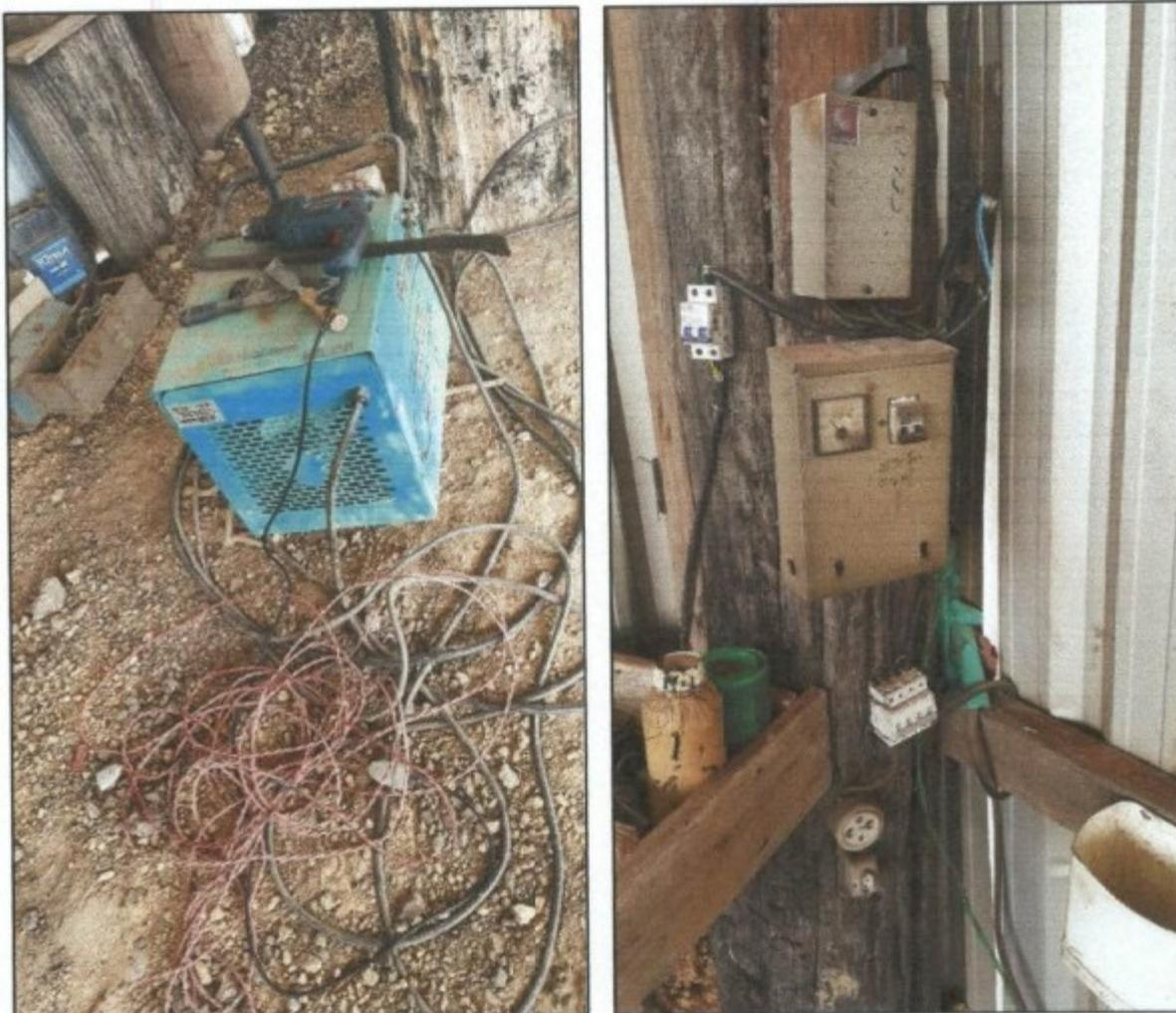
Fotos: Fios elétricos e disjuntores que acarretavam riscos de choques e outros acidentes.
