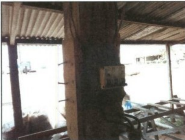
Fotos: Dispositivos de acionamento das máquinas da Fazenda (disjuntores e chaves "Lombard").
