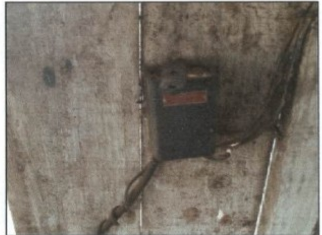
Fotos: Dispositivos de acionamento das máquinas da Fazenda (disjuntores e chaves "Lombard").
