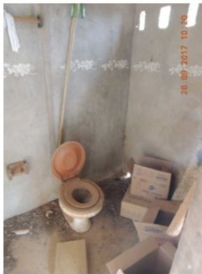
Interior do banheiro desativado.
