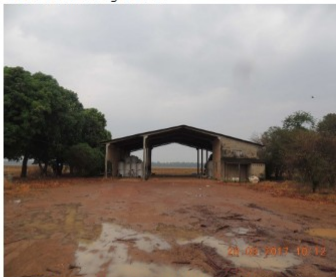
Galpão onde estavam alojados os trabalhadores.
