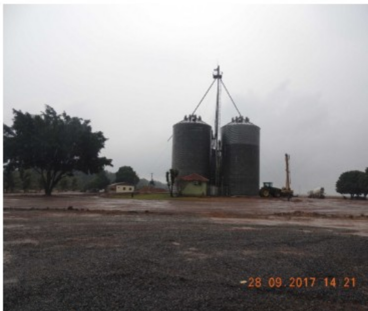
Instalações de silos e secador na fazenda 2 Irmãos.
