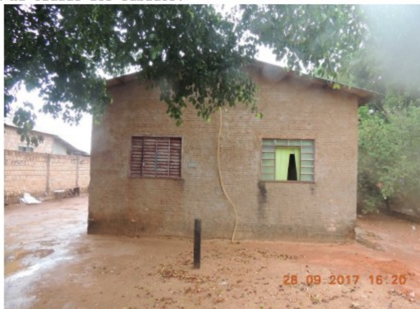
Casa na cidade de Ipiranga do Norte onde ficam alojados os trabalhadores.
