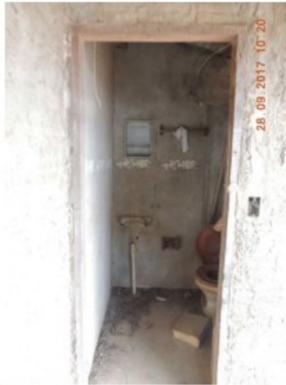
Banheiro desativado no galpão.
