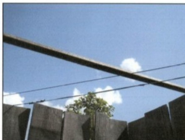
Fotos: Banheiro improvisado na parte externa do alojamento, que era usado pelo trabalhador para tomar banho.
