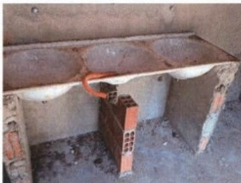
Fotos 12, 13 e 14: casa inacabada destinada à alojamento de trabalhadores no Retiro do [REDACTED]
