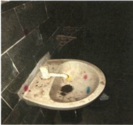
Figura 3: lavatório presente no banheiro que havia na casa.
