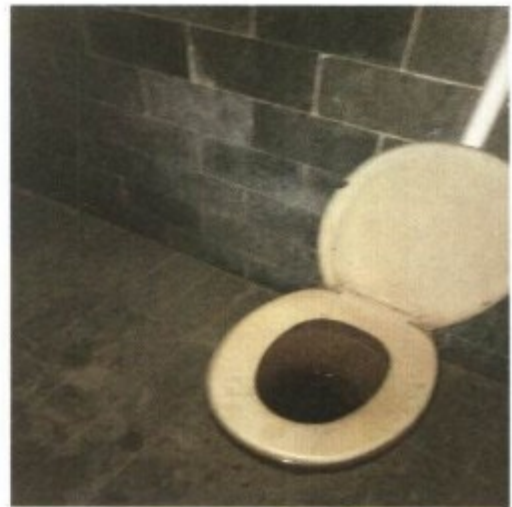
Figura 4: vaso sanitário presente no banheiro que havia na casa.
