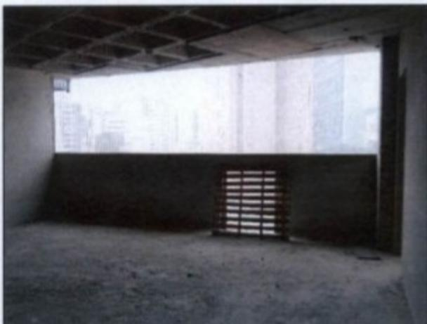
Abertura na parede sem fechamento adequado (sem fixação)
