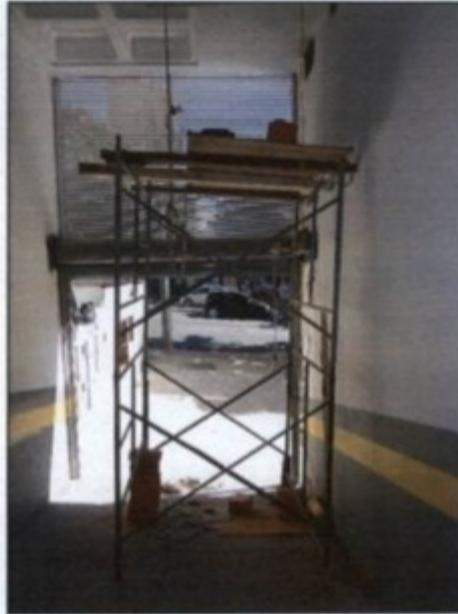
*Andaime montado na rampa da garagem sem guarda-corpo e com piso incompleto*
