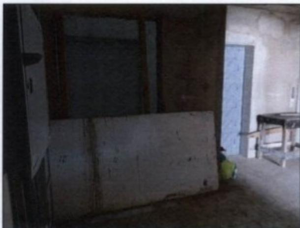
Vão de elevador com chapa de "madeirite" meramente apoiada
