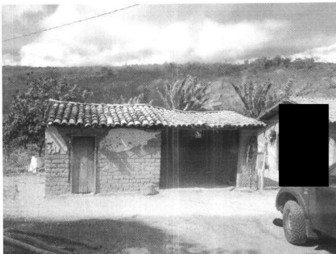
Foto 1: galpão onde estava o dormitório do trabalhador [REDACTED]
