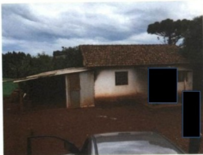
Vista externa da casa onde está alojado o trabalhador
