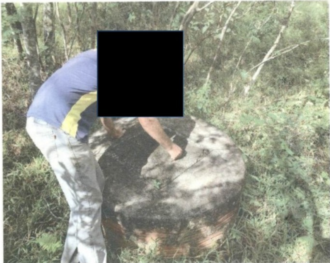
Estrutura de captação e vedação da Mina d'água.
