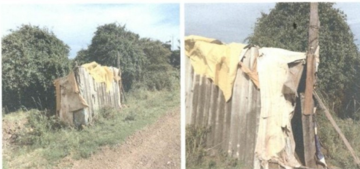
Barraca que supostamente seria utilizada como banheiro pelos obreiros.
