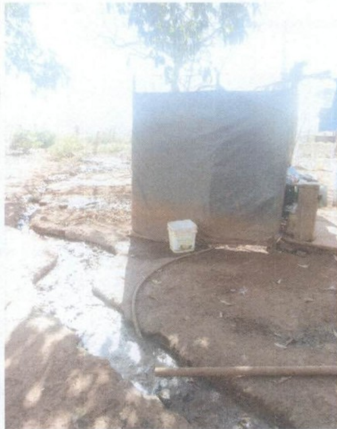
ESGOTO A CÉU ABERTO E CHUVEIRO IMPROVISADO
