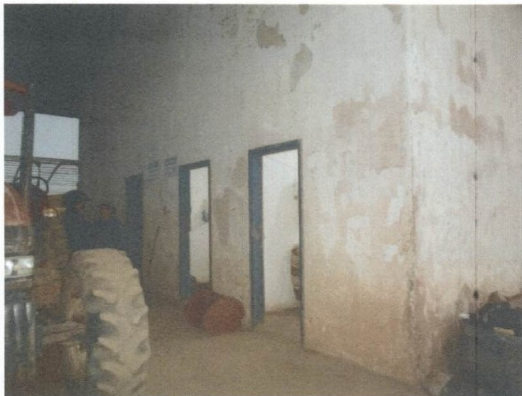
VISTA GERAL DO ALOJAMENTO OCUPADO PELOS SERRALHEIROS
