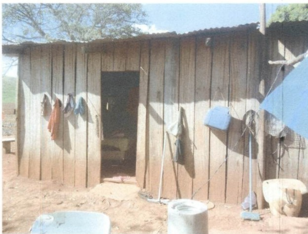
CÔMODO DE MADEIRA, CONSTRUÍDO PELOS PRÓPRIOS TRABALHADORES
