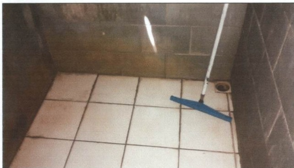
Fotos: Instalações sanitárias do alojamento.
