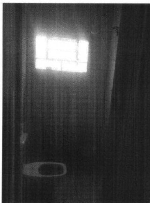
FOTO 6: Instalação sanitária do alojamento.
