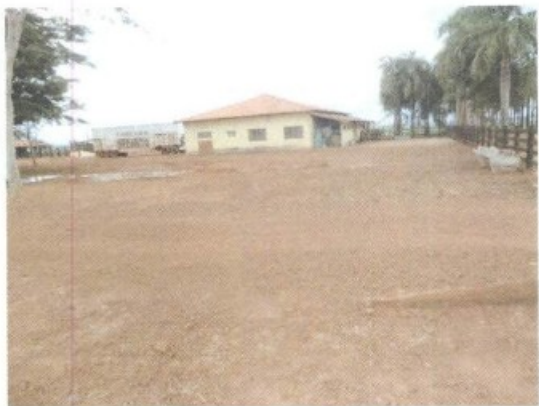
Foto 04: Vista Lateral do Alojamento
