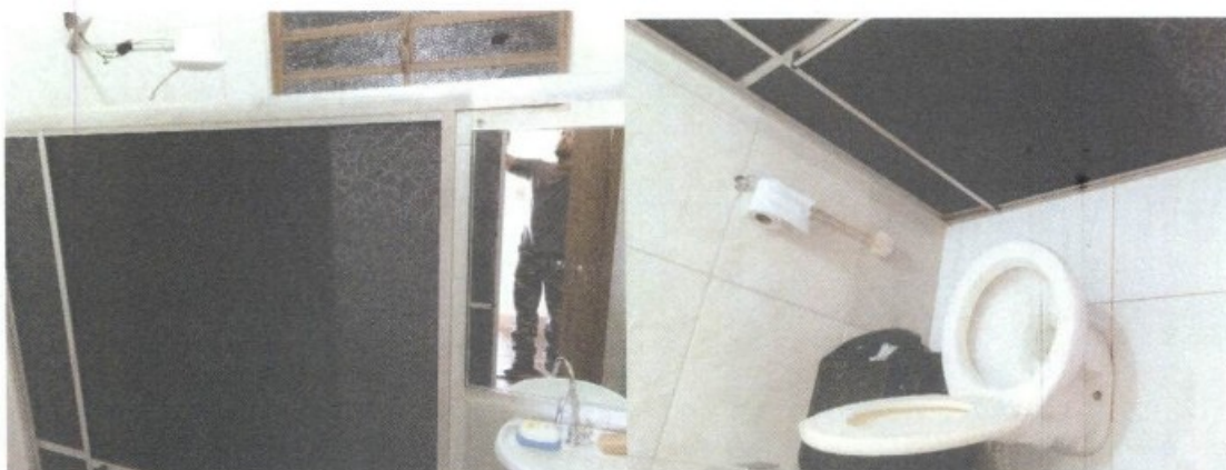
Foto 11: Banheiro feminino - alojamento
