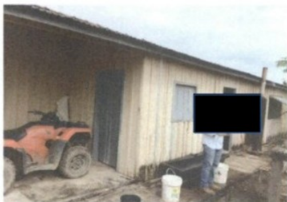
Foto 02: Visão lateral da moradia familiar
