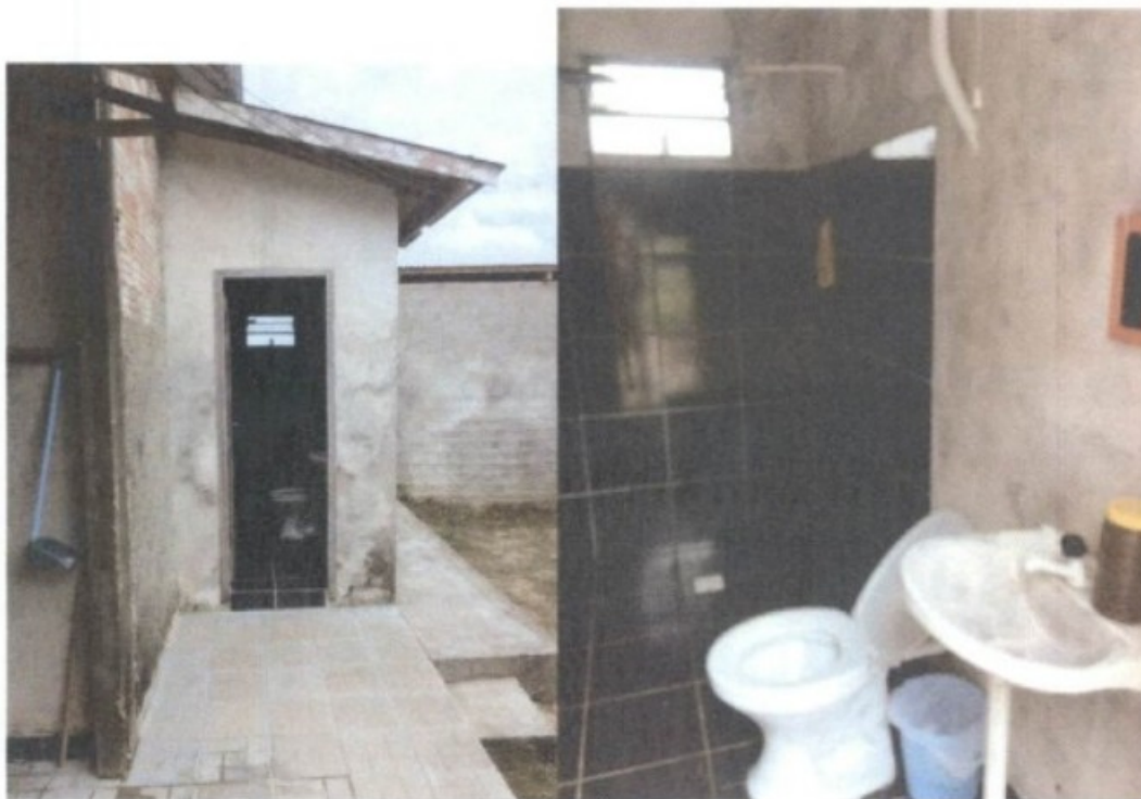
Foto 11 e 12: Banheiro do alojamento, área externa.
