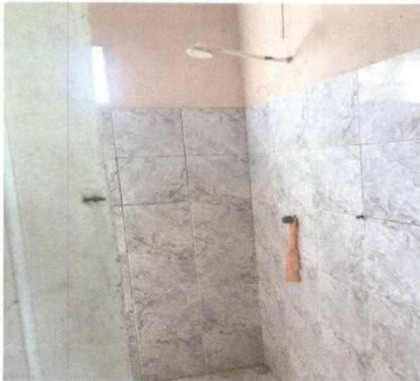
Foto: Banheiro do alojamento – empregados roçada
