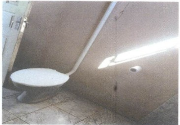
Foto: Banheiro do alojamento – empregados roçada
