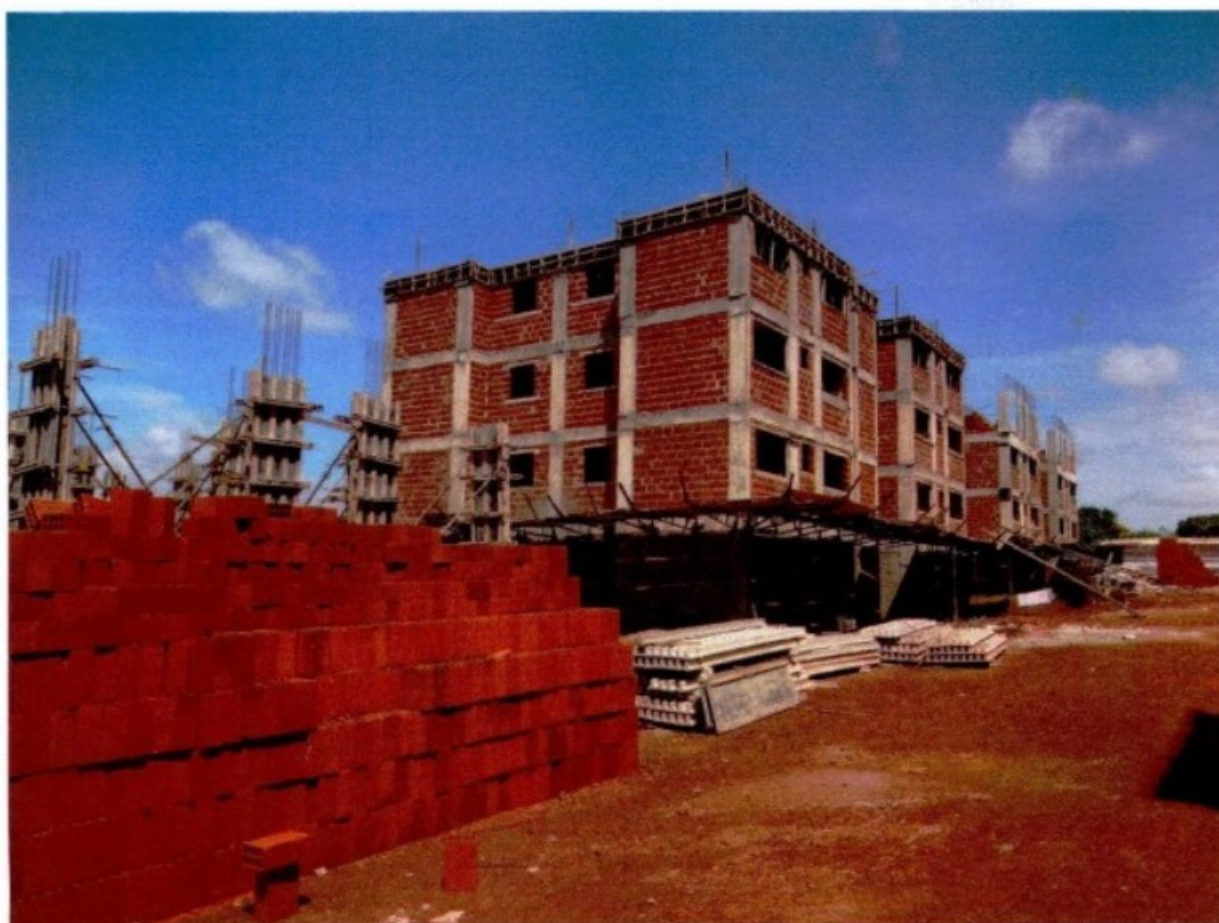
Foto001 – Canteiro de obra finalizado.
