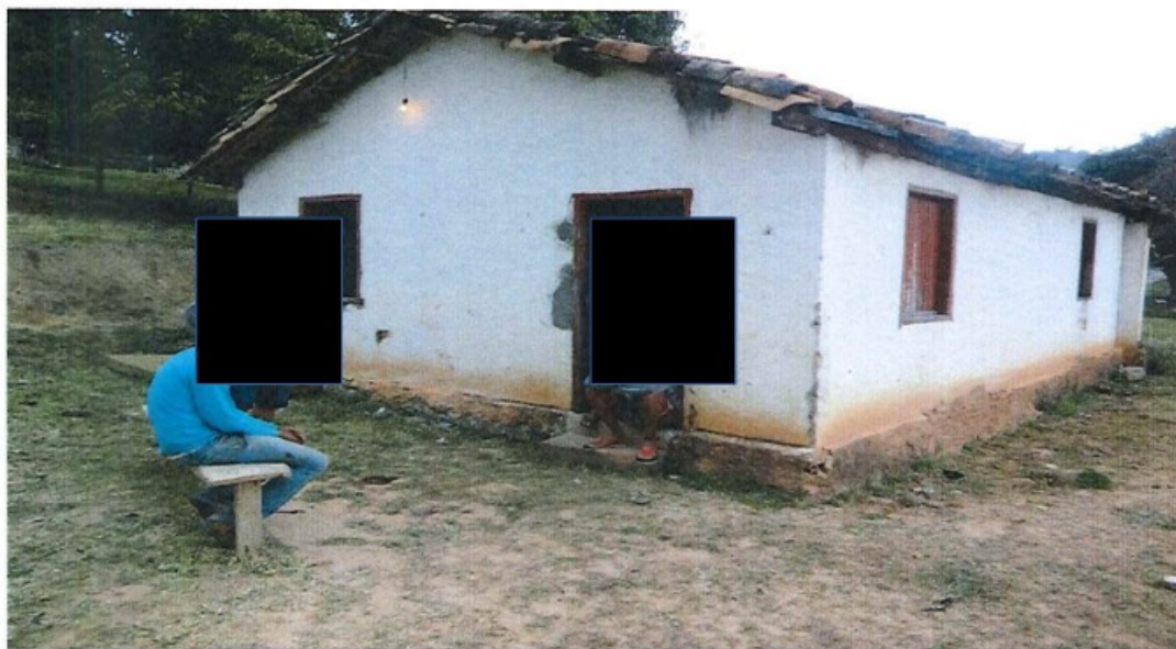
Foto 03 -Vista geral de uma das casas utilizadas como alojamento.
