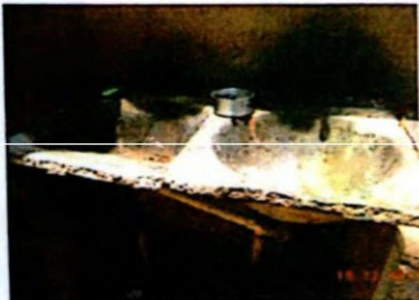
Tanque de duas cubas utilizado para lavar roupas: danificado, bordas cortantes não sevidas de água, expondo trabalhadores a riscos de acidente.
