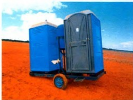
Sanitários subdimensionados em posição inclinada, sem água no reservatório e lavabos quebrados
