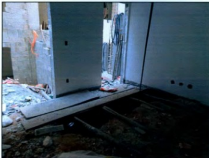
Mais aberturas no piso de trabalho.
